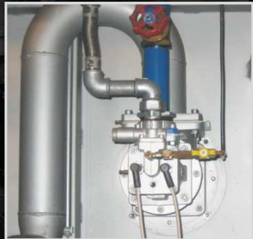
Quemadores dobles de alta velocidad aire con tubo de llama SiC
